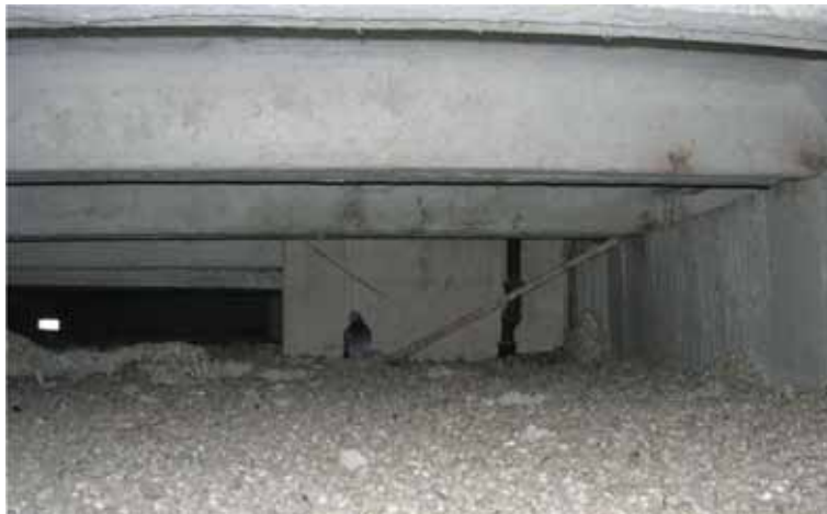
Joonis 3.18 Narvas asuva Tüüpseeria 84 keramsiitkruusaga soojustatud katuslagi
