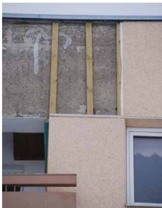
Joonis 3.12 Hoone renoveerimistööd: fassaadi katmine ilma lisasoojustamata on kalline ettevõtmine ja energiasäästu ei võimalda.
