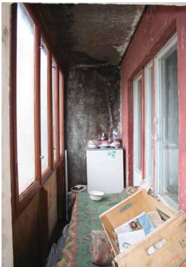
Joonis 3.28 Näide, kuidas lodža kinniehitamine on põhjustanud hallituse vohamise lodža sisepindadel. Üleval: vaade kinniehitatud rõdust. All vasakul: kinniehitatud rõdu enne remonti, all paremal: kinniehitatud rõdu pärast remonti. Kuna hallituse tekke põhjust ei ole likvideeritud on lodža seintele tekkinud uuesti hallitus.
