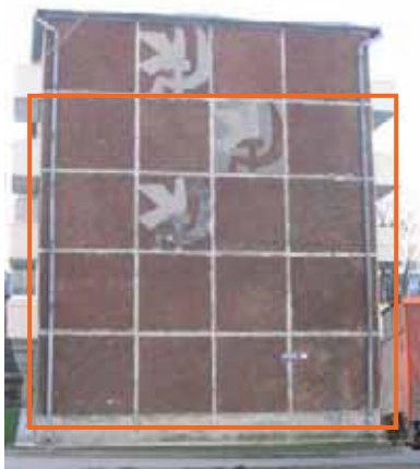
Joonis 7.9 Suurpaneelilamute tüüpseeria 464 otsasein
