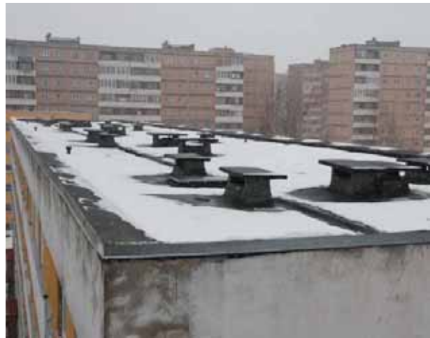
Joonis 3.18 Narvas asuva Tüüpseeria 84 keramsiitkruusaga soojustatud katuslagi
