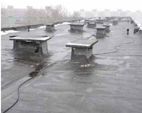
Joonis 3.18 Narvas asuva Tüüpseeria 84 keramsiitkruusaga soojustatud katuslagi
