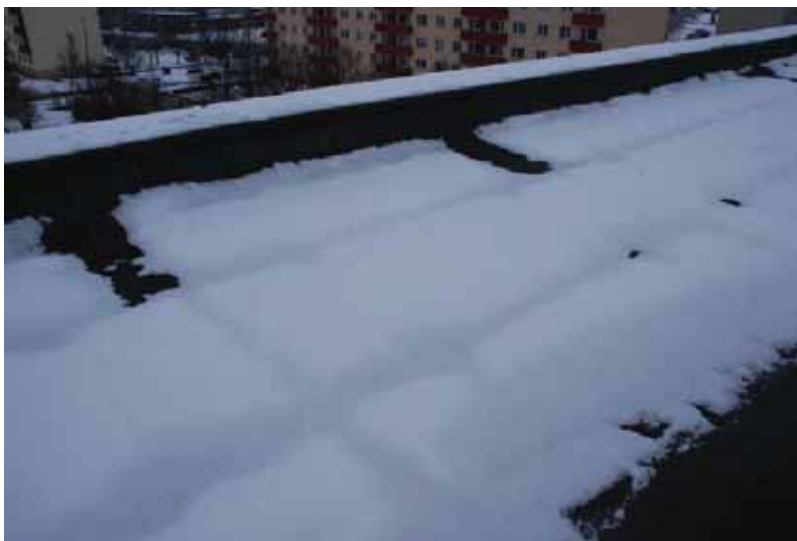
Joonis 3.17 Seeria 133 elamu katuslagi. Õhemaks sulanud kohad markeerivad tuulutuskanalid ja sulanud kohad parapeti servas markeerivad tuulutuskanalite parapetist väljatuleku kohti.
