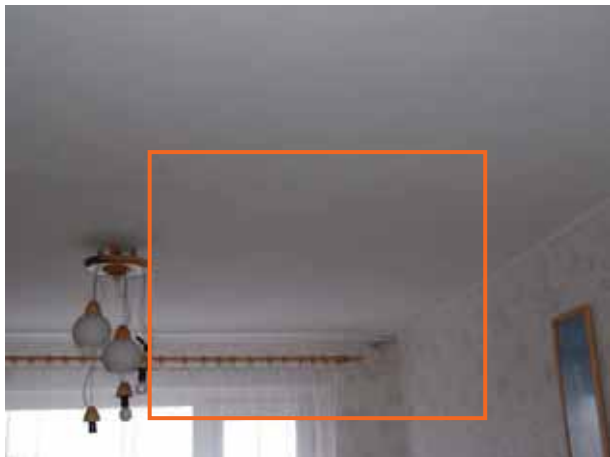
Joonis 7.14 Hallituse kasv suurpaneelilamute tüüpseeria 464 pikiseina ja katuslae liitekohas oleval külmasillal. Tulenevalt katuslae suurest soojajuhtivusest joonistuvad katuslae külmasillad hästi välja.
