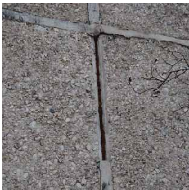
Joonis 3.3 Tsementmört on jäik ja ei sobi vuukide täiteks
