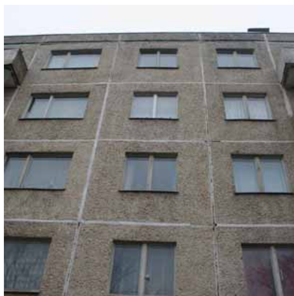
Joonis 3.4 Päikesekiirgus lagundab vuugitäiteks kasutatud montaaživahu kiiresti ja raha on kulutatud asjata
