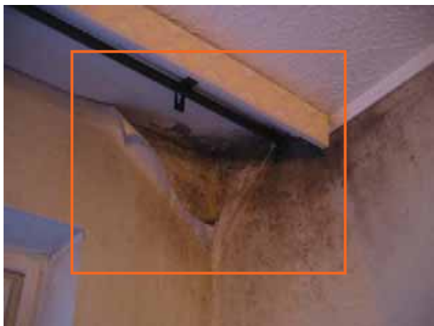
Joonis 7.15 Hallituse kasv suurpaneelilamute tüüpseeria 121 otsaseina ja katuslae liitekohas oleval külmasillal.
