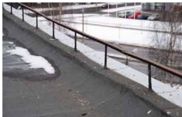
Joonis 3.26 Katuslae ja välisseina liitekohta ning otsaseina lisasoojustamine (vasakul). Madala parapeti korral tuleb katuse serva ehitada piire (paremal).
