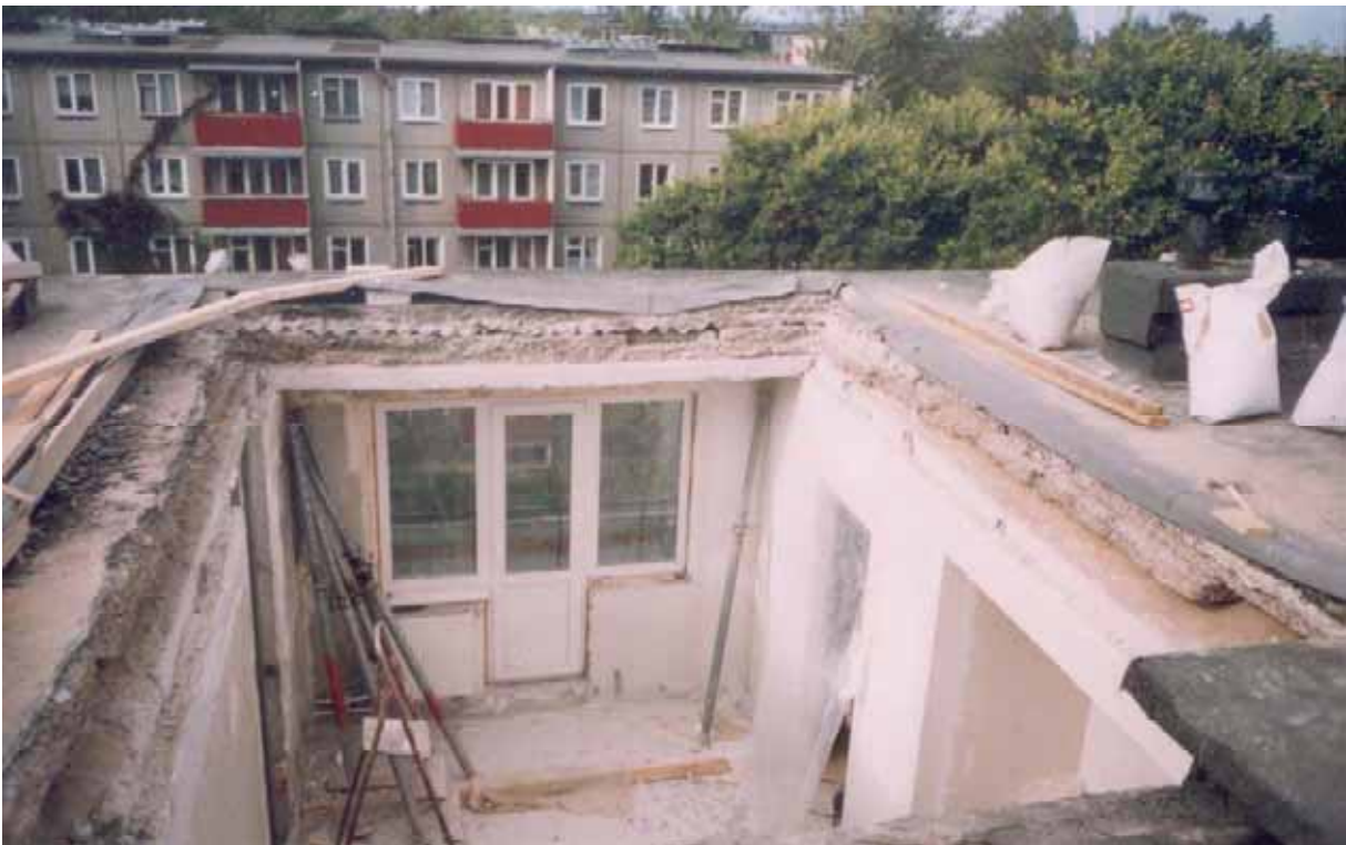
Joonis 3.14 Tallinnas asuva seeria 464A elamu kahjustunud katuslagi (ülal) on eemaldatud (all) ja ehitati uuesti monoliitbetoonist
