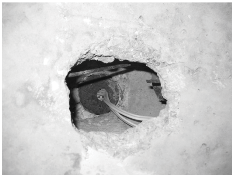
Joonis 3.32 Kohakuti pistikupesad kahe korteri vahelises seinas.
