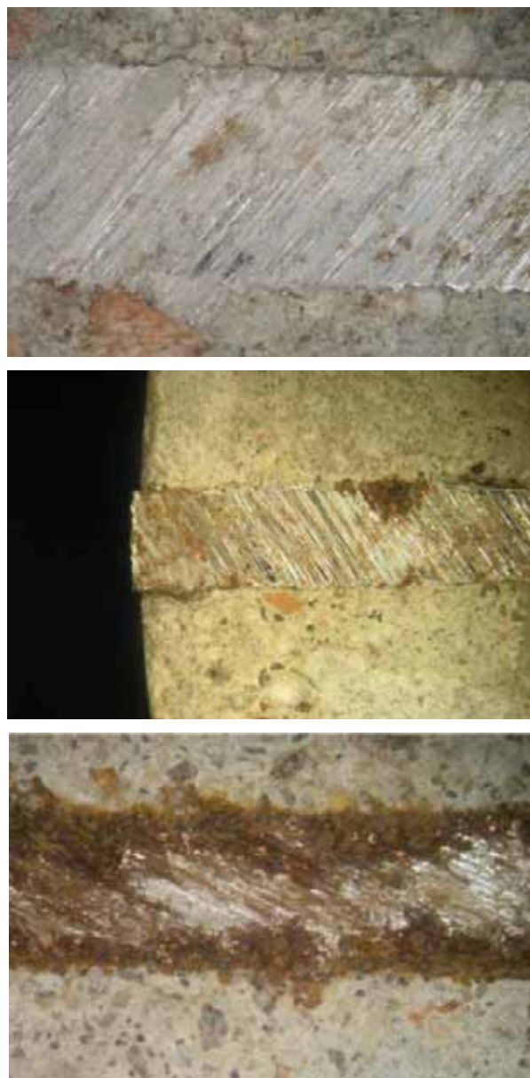
Joonis 5.27 Korrosioonita armatuur (ülal), betooni armatuurraud korrodeerunud üksikute peade kaupa (keskel), armatuuriraud valdavalt korrodeerunud (all).
