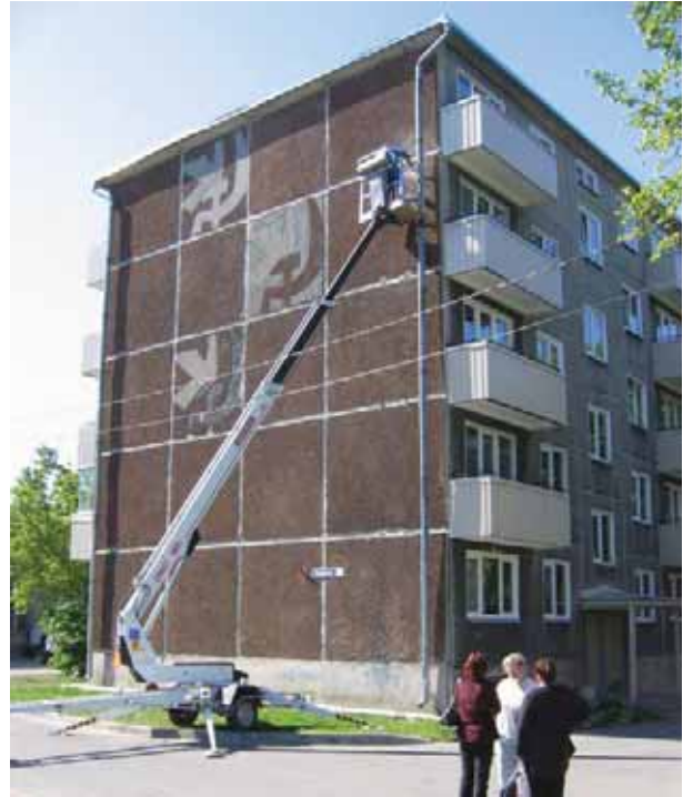
Joonis 3.9 Välisseinapaneelidest proovikehade võtmine hoone erinevatelt kõrgustelt
