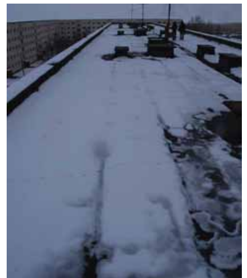
Joonis 3.17 Seeria 133 elamu katuslagi. Õhemaks sulanud kohad markeerivad tuulutuskanalid ja sulanud kohad parapeti servas markeerivad tuulutuskanalite parapetist väljatuleku kohti.
