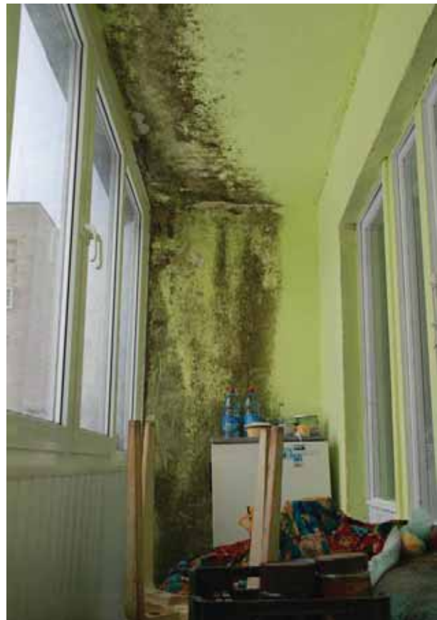
Joonis 3.28 Näide, kuidas lodža kinniehitamine on põhjustanud hallituse vohamise lodža sisepindadel. Üleval: vaade kinniehitatud rõdust. All vasakul: kinniehitatud rõdu enne remonti, all paremal: kinniehitatud rõdu pärast remonti. Kuna hallituse tekke põhjust ei ole likvideeritud on lodža seintele tekkinud uuesti hallitus.
