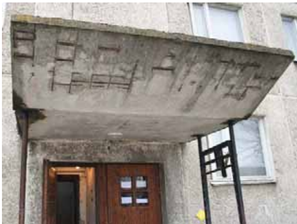
Joonis 3.27 Rõduplaatide ja varikatuste kahjustused (vasakul). Rõdude meelevaldne kinniehitamine rikub hoone arhitektuurset välimust (paremal)
