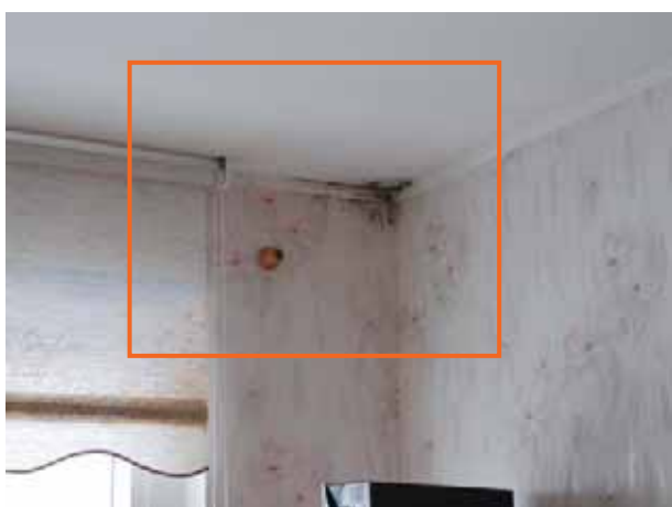
Joonis 7.13 Hallituse kasv suurpaneelilamute tüüpseeria 464 pikiseina ja katuslae liitekohas oleval külmasillal.
