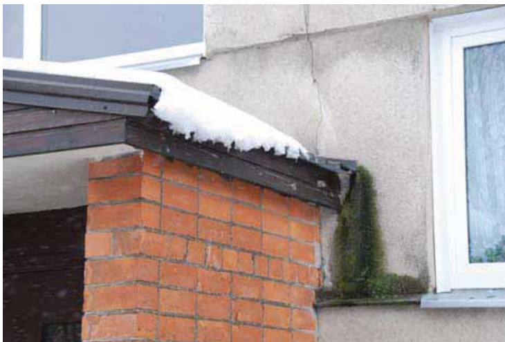
Joonis 3.22 Sadevee probleemid varikatuste juures
