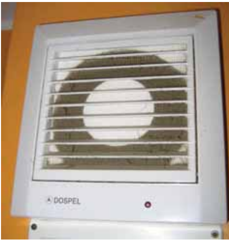
Joonis 13.3 Ventilatsioonilõõrid on siseruumides suletud või olukorras, mis takistavad õhu läbivoolu.
