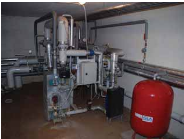
Joonis 15.1 Uus soojussõlm
