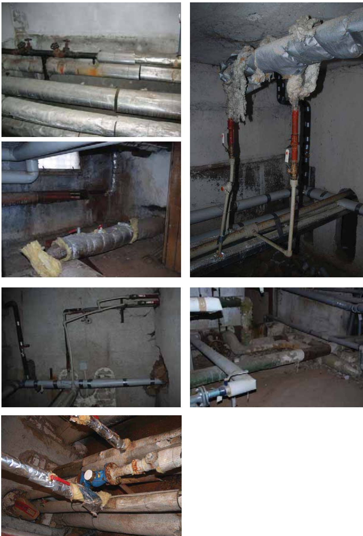
Joonis 15.2 Osaliselt soojustatud või soojustamata küttemagistraalid keldris.
