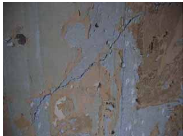
Joonis 3.31 Kaldpragu põikikandeseinas, mis lõppes rõdu tõmbi juures.
