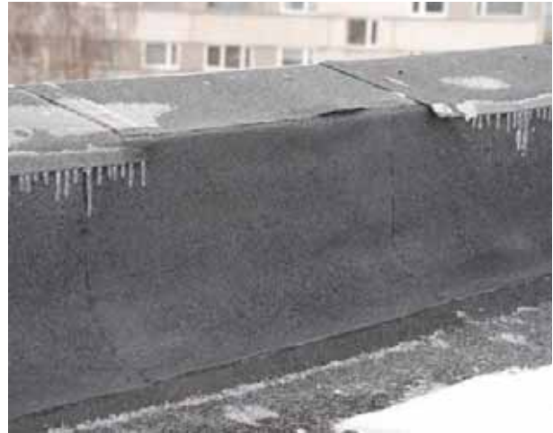
Joonis 3.21 Veeloike katuslael põhjustavad ummistunud sadevee äravoolu lehtrid ja ebapiisavad kalded.
