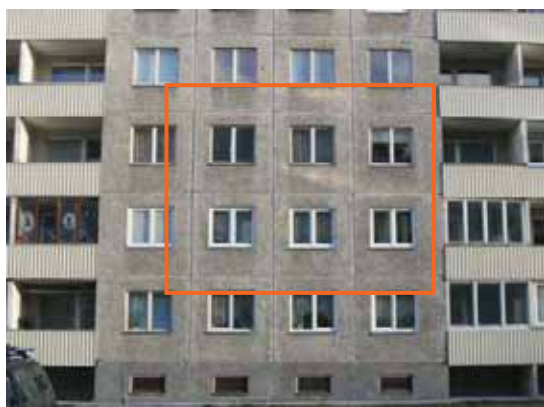
Joonis 7.6 Suurpaneelilamute tüüpseeria 121 pikisein
