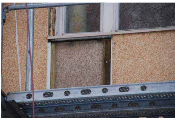
Joonis 3.12 Hoone renoveerimistööd: fassaadi katmine ilma lisasoojustamata on kalline ettevõtmine ja energiasäästu ei võimalda.
