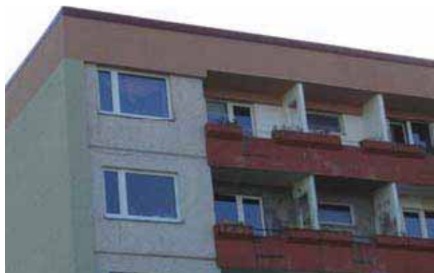
Joonis 3.26 Katuslae ja välisseina liitekohta ning otsaseina lisasoojustamine (vasakul). Madala parapeti korral tuleb katuse serva ehitada piire (paremal).
