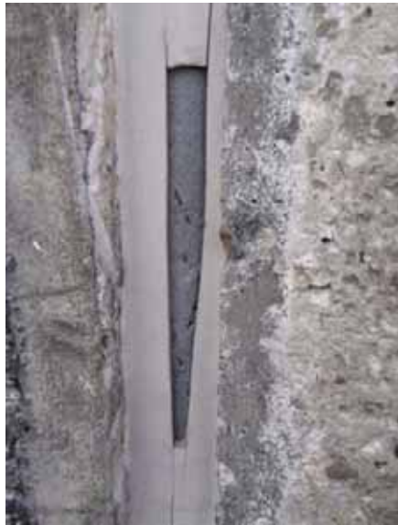
Joonis 3.5 Lõhutud vuugihernetik
