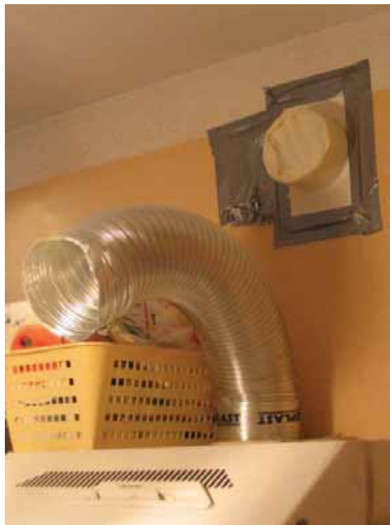
Joonis 8.3 Õhupidavuse mõõtmise ajaks suleti kõik ventilatsiooniavad
