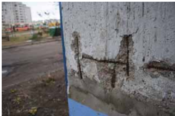
Joonis 3.7 Välisseina korrodeerunud armatuur
