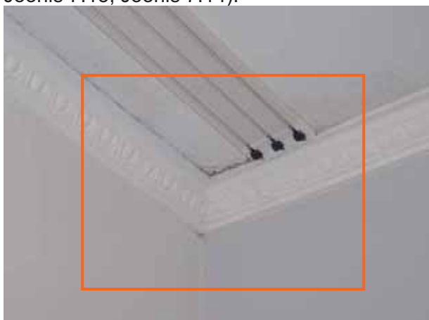
Joonis 7.11 Hallituse kasv suurpaneelilamute tüüpseeria 111-133 otsaseina ja katuslae liitekohas oleval külmasillal
