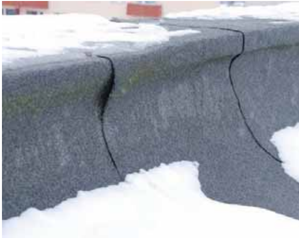
Joonis 3.21 Veeloike katuslael põhjustavad ummistunud sadevee äravoolu lehtrid ja ebapiisavad kalded.
