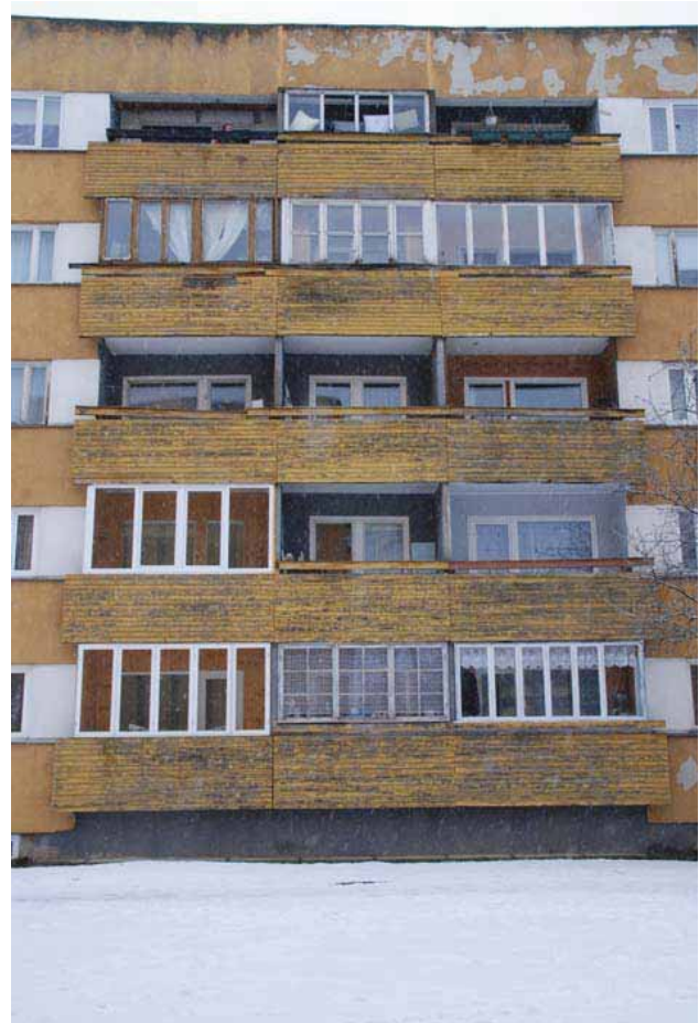
Joonis 3.27 Rõduplaatide ja varikatuste kahjustused (vasakul). Rõdude meelevaldne kinniehitamine rikub hoone arhitektuurset välimust (paremal)
