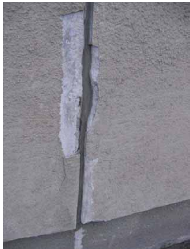
Joonis 3.6 Halva nakke tõttu on vuugihernetik vuugi serva küljest lahti tulnud
