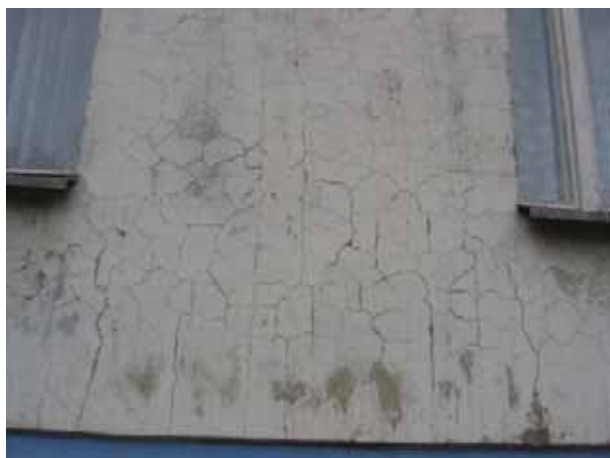
Joonis 3.8 Kahjustunud fassaadivärv (vasakul) ja krohv (paremal)
