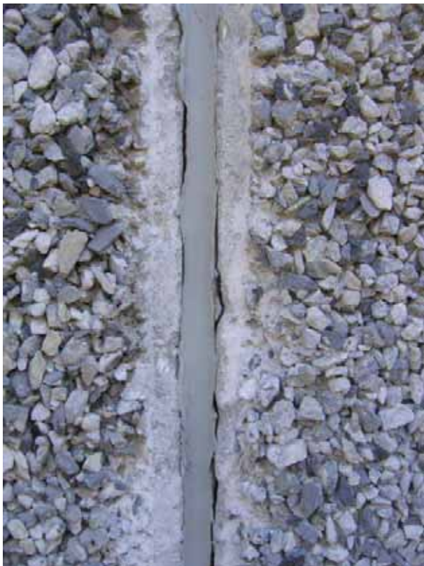
Joonis 3.6 Halva nakke tõttu on vuugihernetik vuugi serva küljest lahti tulnud
