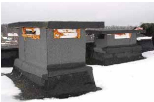
Joonis 13.2 Ventilatsioonilõõrid on katusel suletud.
