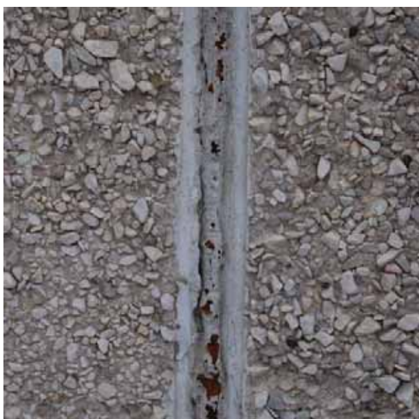
Joonis 3.4 Päikesekiirgus lagundab vuugitäiteks kasutatud montaaživahu kiiresti ja raha on kulutatud asjata
